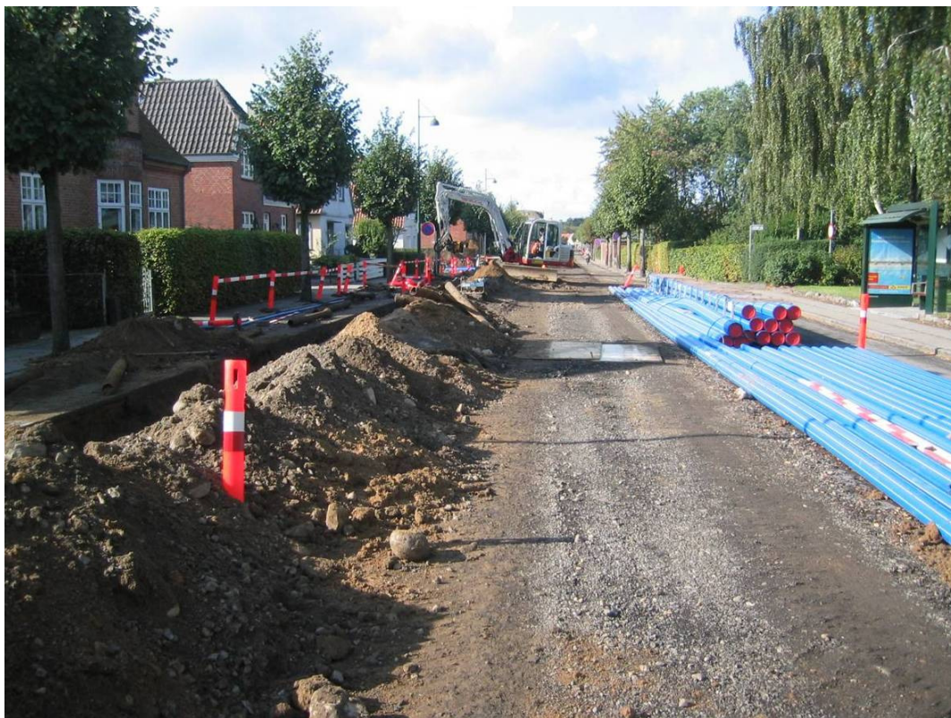
Figur 3.5 Ledningsarbejde (Foto: Grontmij | Carl Bro)
